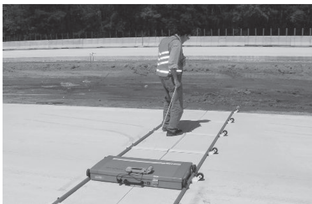
Figure 1. Dowel bar alignment testing using MIT Scan-2.
